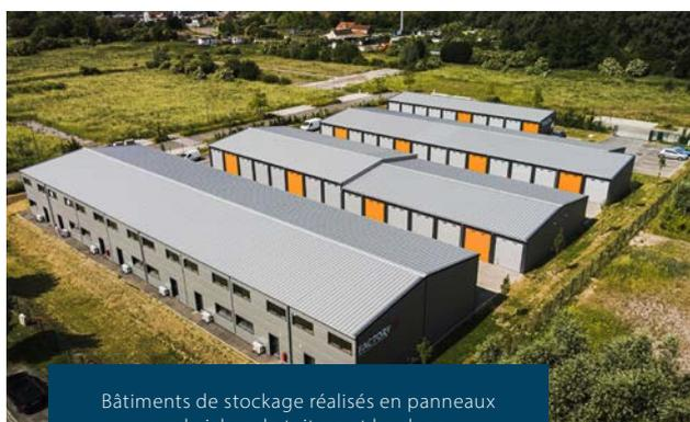
Bâtiments de stockage réalisés en panneaux sandwichs de toiture et bardage.
