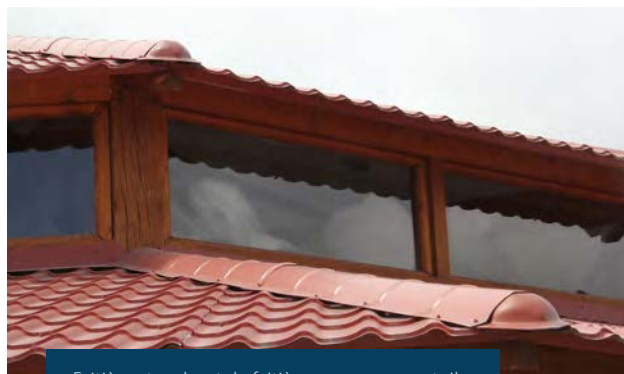
Faitière et embout de faitière pour panneau tuile.
