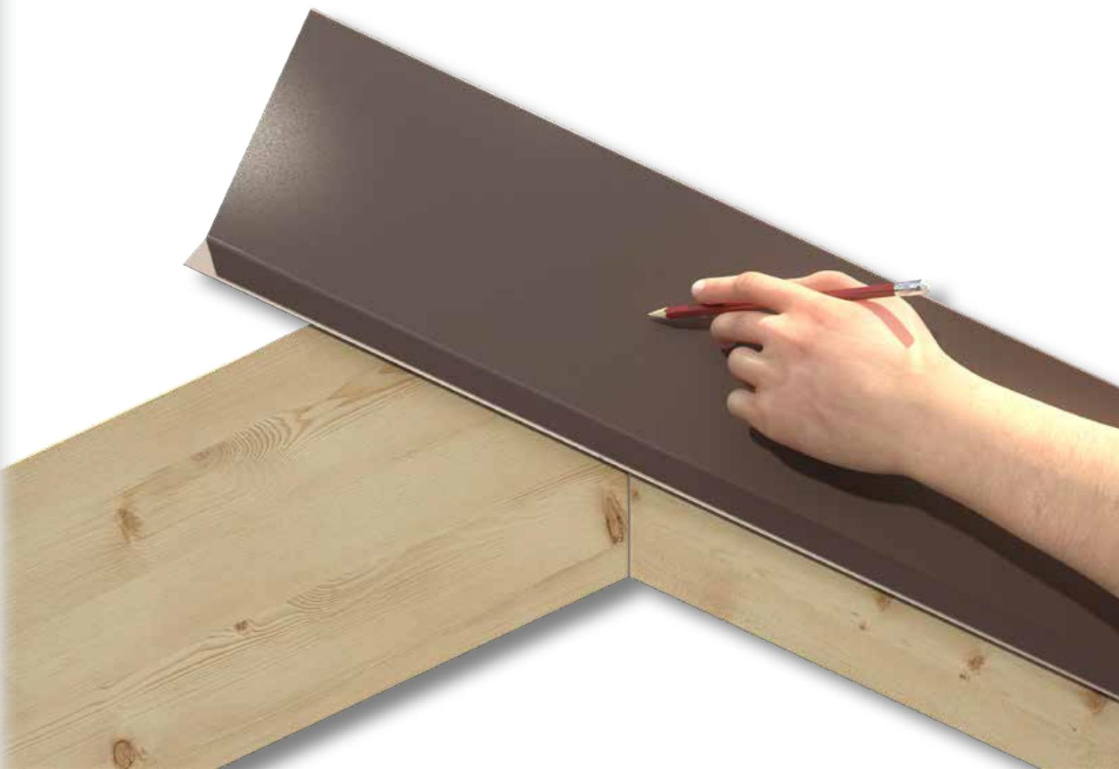
Profilul pazie se montează începând din streașină spre coamă, trasați și tăiați excesul. Fixați pazia pe partea de pazie de lemn cu șuruburi de fixare din metru în metru.
