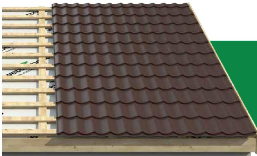
Cel de al doilea panou se va alinia cu primul prin împingere față de primul panou. Cele două panouri vor fi fixate între ele cu șuruburi de coasere înaintând dinspre streașină spre coamă.
