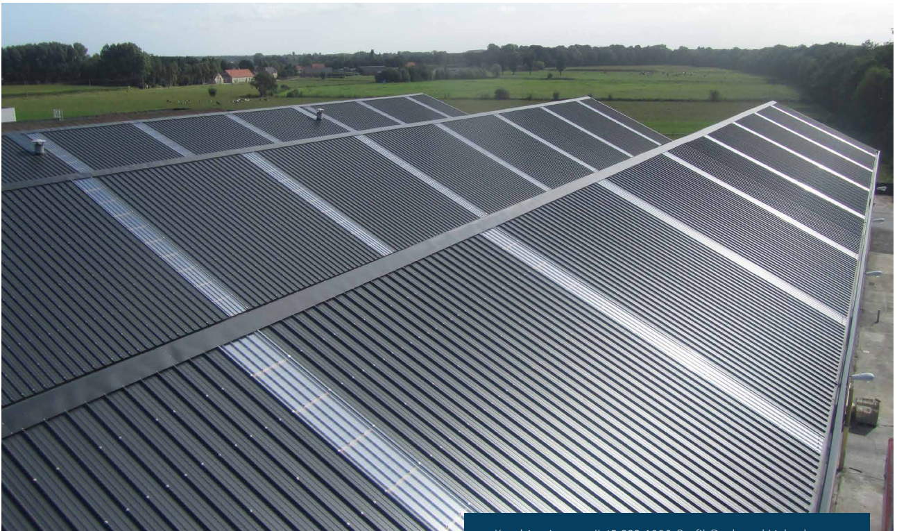
Kombination aus JI 45-333-1000-Profil-Dach und Lichtplatten.
