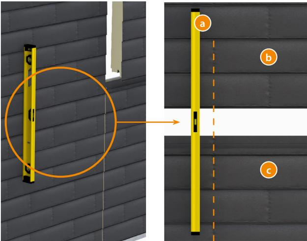
Il est important ici, avant que les panneaux ne soient effectivement emboîtés les uns dans les autres, qu'il soit contrôlé si le joint entre les ardoises est bien placé.
