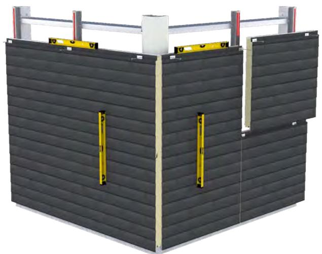
Une fois les panneaux inférieurs montés, c'est au tour des panneaux supérieurs.
