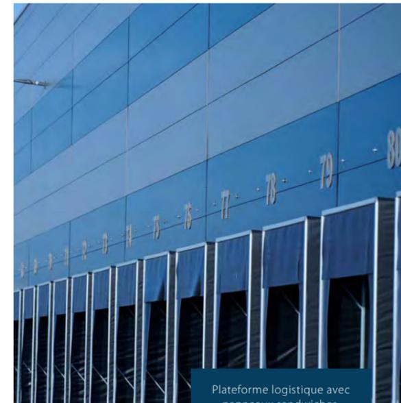
Plateforme logistique avec panneaux sandwichs.
