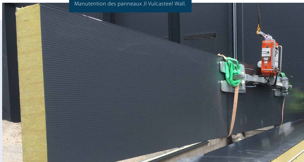
Manutention des panneaux JI Vulcasteel Wall.
