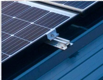
Le procédé JORISOLAR RS-EVO est un système fixé à la structure du bâtiment sans perçage supplémentaire dans la toiture.
