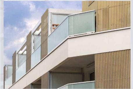
A l'instar de la gamme de profils perforés, JORIS IDE propose également un panel de lames rapportées spécifiques permettant d'occulter les organes de fixation.
