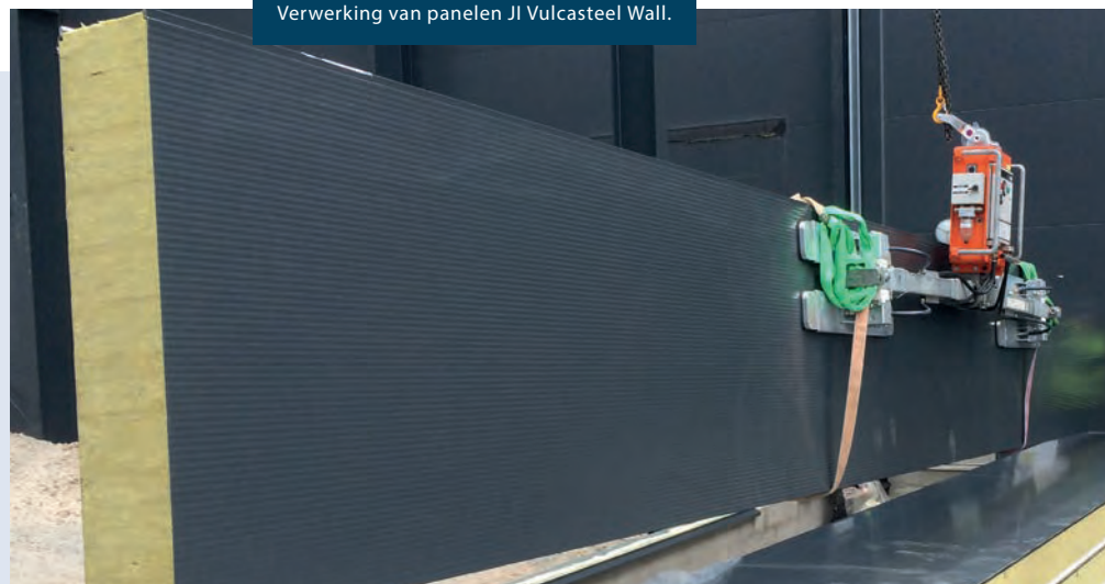
Verwerking van panelen JI Vulcasteel Wall.
