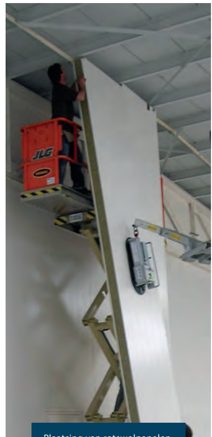
Plaatsing van rotswolpanelen.
