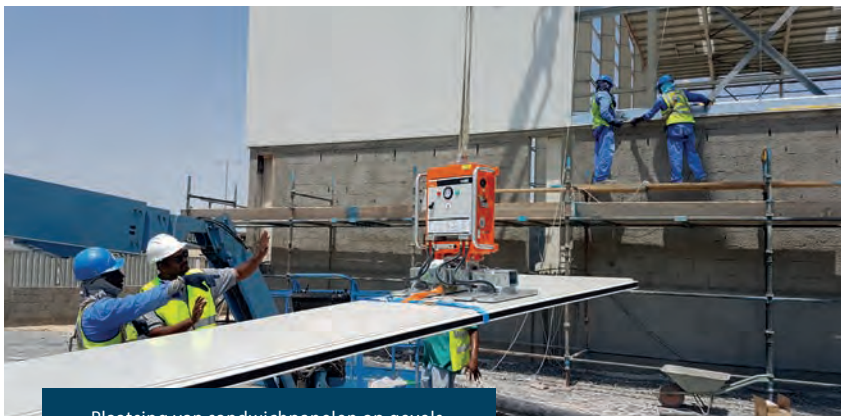
Plaatsing van sandwichpanelen op gevels.
