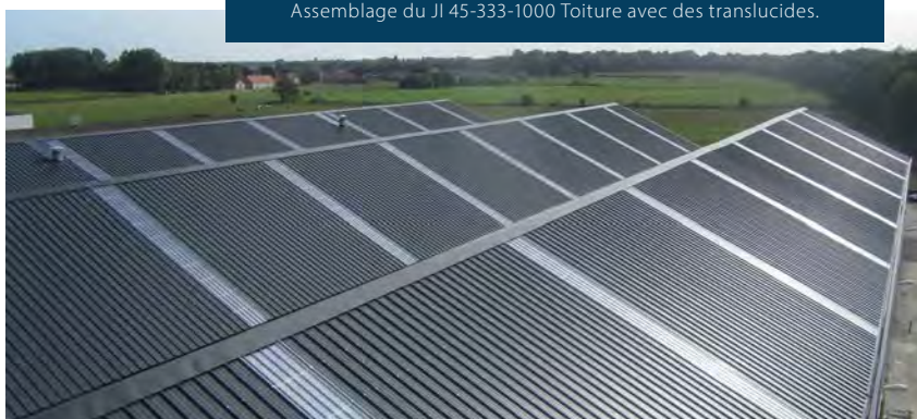
Assemblage du JI 45-333-1000 Toiture avec des translucides.
