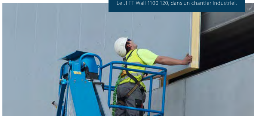
Le JI FT Wall 1100 120, dans un chantier industriel.
