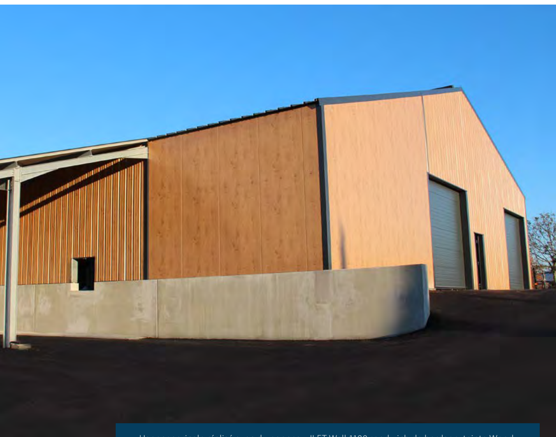
Hangar agricole réalisé avec du panneau JI FT Wall 1100 sandwich de bardage, teinte Wood.
