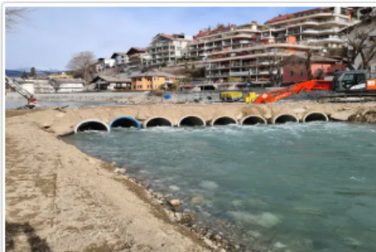
L'Isarco viene ampliato a Bressanone all'altezza dell'Acquarena per rafforzare la protezione dalle inondazioni. (Foto: ASP/Ufficio Sistemazione bacini montani nord)
