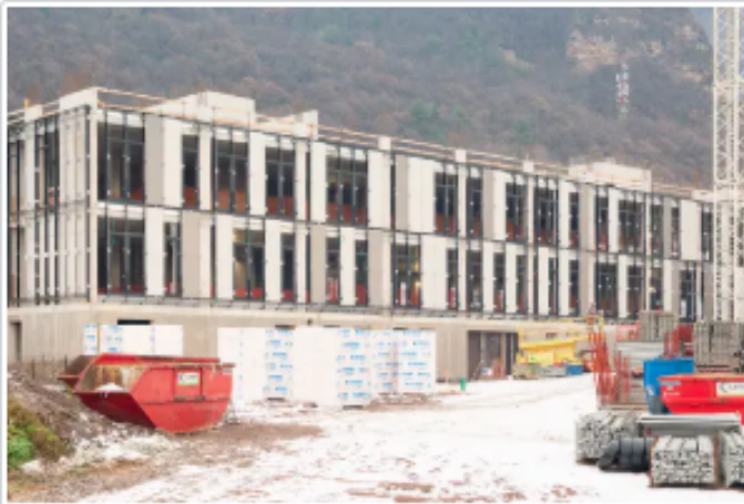
Foto: Baustelle des Gemeinschaftshauses Leifers, Abteilung Hochbau und technischer Dienst der Autonomen Provinz Bozen
