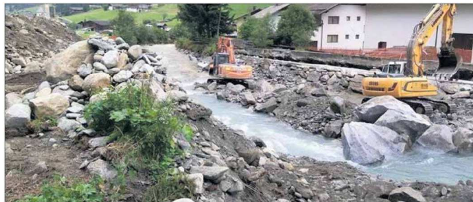
Das Amt für Wildbach- und Lawinenverbauung Ost der Agentur für Bevölkerungsschutz arbeitet in und an der Ahr in Prettau.
