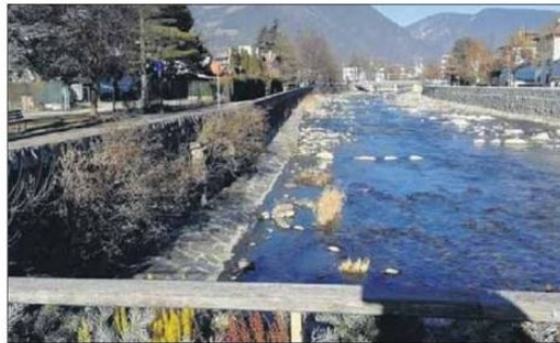
Am orographisch rechten Ufer des Eisacks (links im Bild) beginnen Arbeiten an der Mauer.
