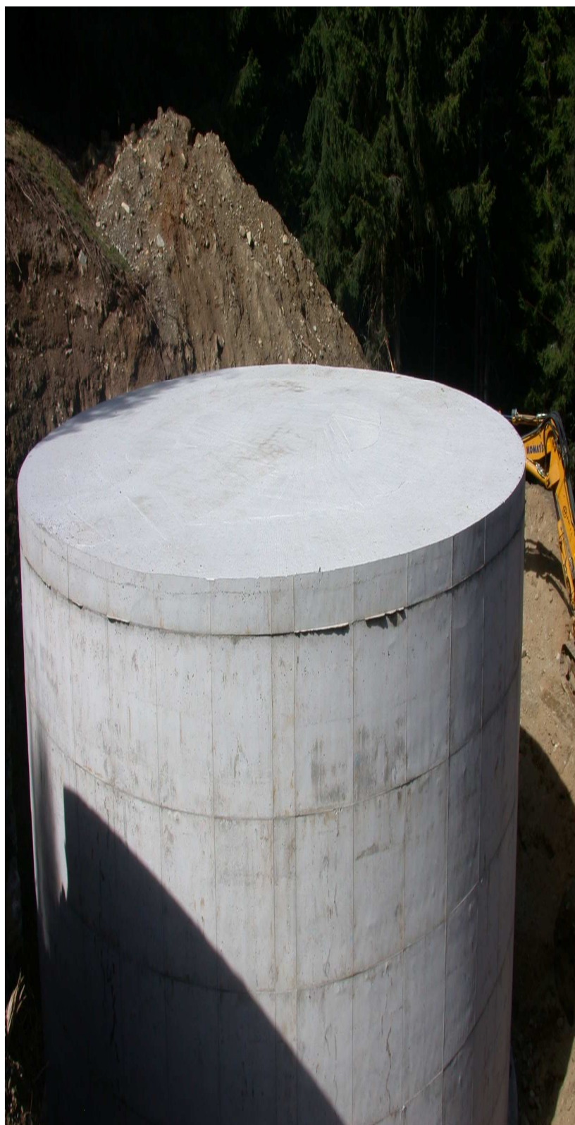
IMMAGINE POST-INTERVENTO (concluso)
