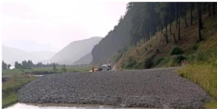
Figura 1 – Immagine della colata detritica che il 25-07-2022 ha invaso la SS 40 (lato Est a sinistra, lato Ovest a destra)
