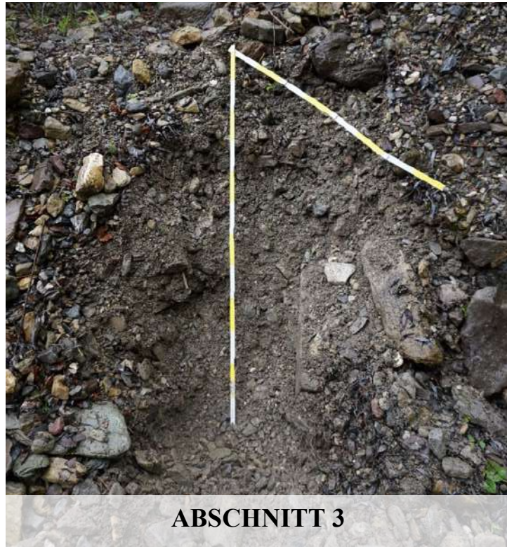
Abbildung 36. Fotografische Dokumentation des Aufschlusses des talseitig gelegenen Sedimentationsbeckens.
