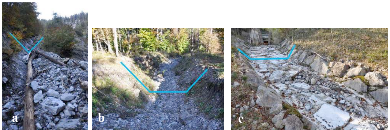
Abbildung 11. Beispiele der Bachläufe, die in den Testgebieten untersucht wurden: a) V-förmig mit Geschiebe; b) trapezförmig mit Geschiebe; c) kanalisiert trapezförmig.
