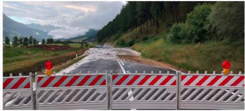
Foto 1 e 2 – Materiale arrivato in strada e autovettura danneggiata
