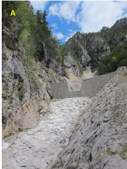
Abbildung 5. Inspektion der hydraulischen Schutzbauten im Einzugsgebiet des Rio Cucco. a) Barriere im obersten Abschnitt des Kanals. b) Becken im untersten Abschnitt des Kanals.
