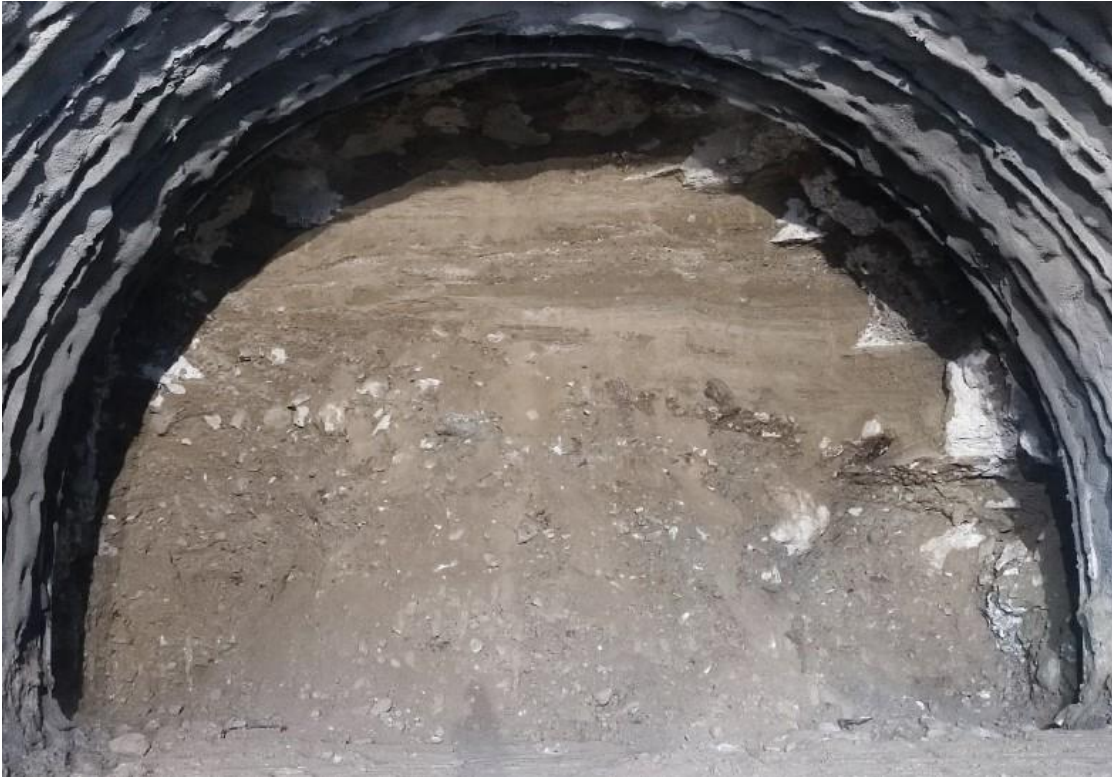
Orstbrust Tunnelvortrieb P.k. 0+632 - Schwemmfächersedimente Fronte di scavo galleria P.k. 0+632 – Depositi di conoide alluvionale
