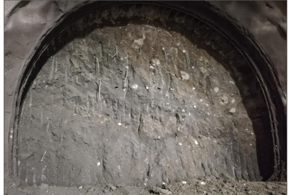
Orstbrust Tunnelvortrieb P.k. 0+808 - Grundmoräne Fronte di scavo galleria P.k. 0+808 – Morena di fondo
