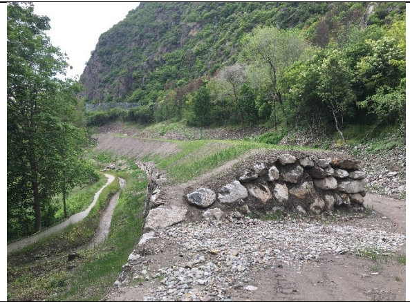
Der abgeschlossene Steinschlagschutzdamm Nr. 2. Il vallo paramassi nr. 2 terminato.
