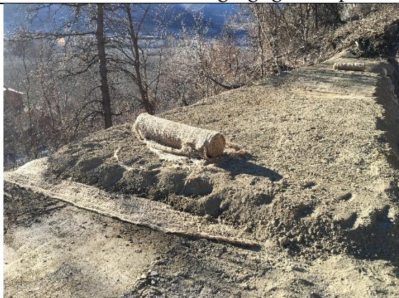
Zwischen Muttererde und Dammschüttung wurde ein Jute Netz ausgebracht. Tra lo strato di terra vegetale e il materiale di riempimento è stato steso una rete di iuta.
