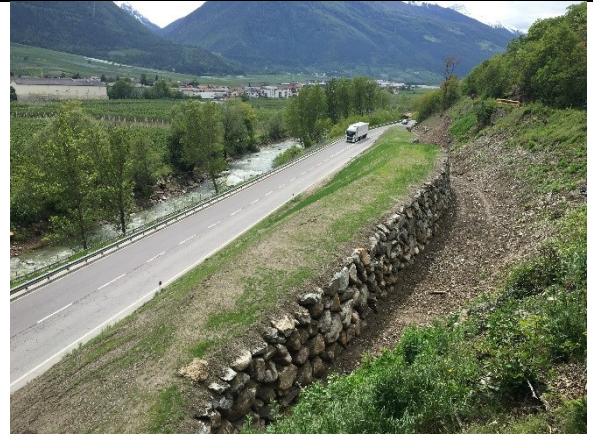
Der abgeschlossene Steinschlagschutzdamm Nr. 1. Il vallo paramassi nr. 1 terminato.
