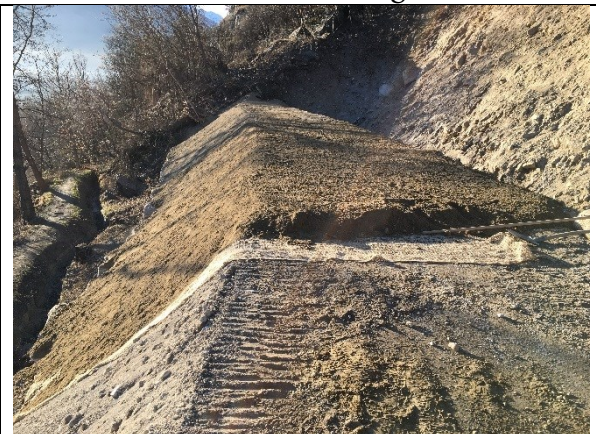
Zwischen Muttererde und Dammschüttung wurde ein Jute Netz ausgebracht. Tra lo strato di terra vegetale e il materiale di riempimento è stato steso una rete di iuta.
