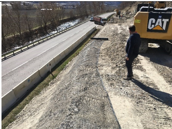
Einbau von Geogitter im Bereich einer Berme und Auftragung Muttererde. Installazione di geogriglia nei pressi di una berma e stesura di terra vegetale.
