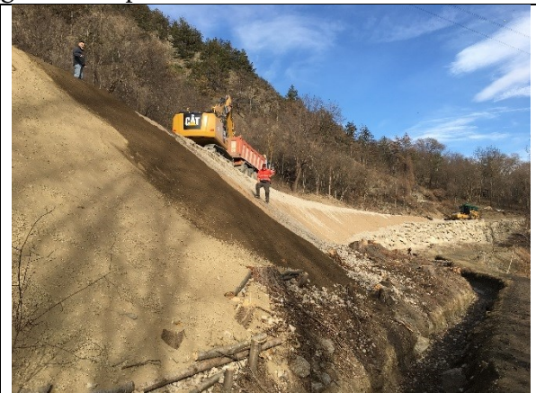
Einbau von Geogitter im Bereich einer Berme und Auftragung Muttererde. Installazione di geogriglia nei pressi di una berma e stesura di terra vegetale.
