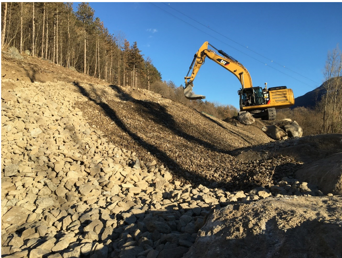
Antikapillarschicht bestehend aus Drainageschüttung und Verzahnungsschicht.
