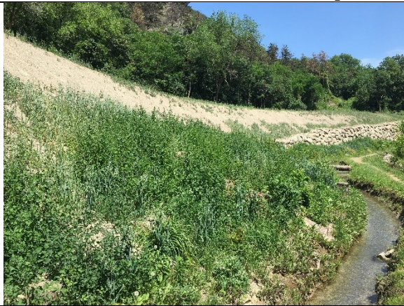
Der abgeschlossene Steinschlagschutzdamm Nr. 2. Il vallo paramassi nr. 2 terminato.
