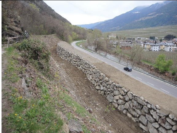
Der abgeschlossene Steinschlagschutzdamm Nr. 1. Il vallo paramassi nr. 1 terminato.
