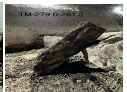
sx: dettaglio con bocchi e ciottoli con vuoti importanti; centro: dettaglio con vuoti, solo parzialmente riempiti; dx: singolo blocco scavato in base calotta, l max. 2,5m
