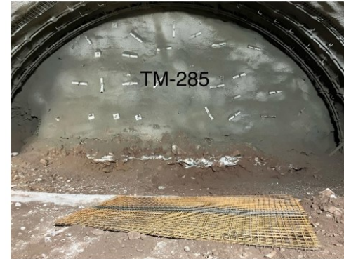
sx: strato-di-bocchi-e-ciottoli-a-base-calotta, dx: dettaglio-con-vuoti, iniettati¶
