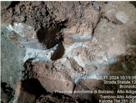
sx: zona con bocchi e ciottoli in alto a sx calotta, dx: dettaglio con vuoti, iniettati
