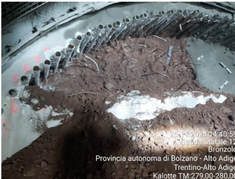
sx: zona con bocchi e ciottoli in alto a sx calotta, dx: dettaglio con vuoti, iniettati
