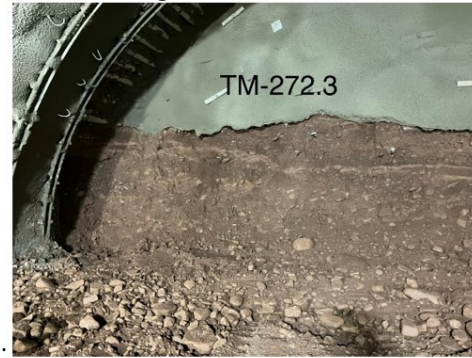
Foto-dallo-scavo-con-sezioni-parziali-con-tipica-composizione-e-struttura¶
