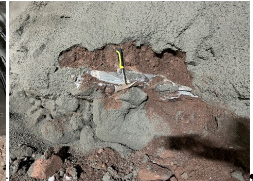
sx: strato-di-bocchi-e-ciottoli-a-base-calotta, dx: dettaglio-con-vuoti, iniettati¶
