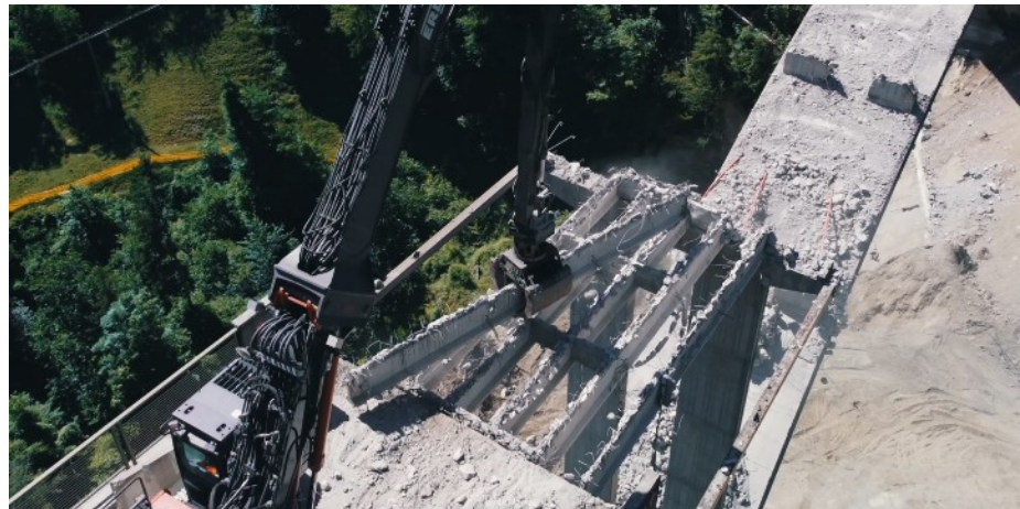
Dettaglio 1b – Demolizione travi longitudinali
