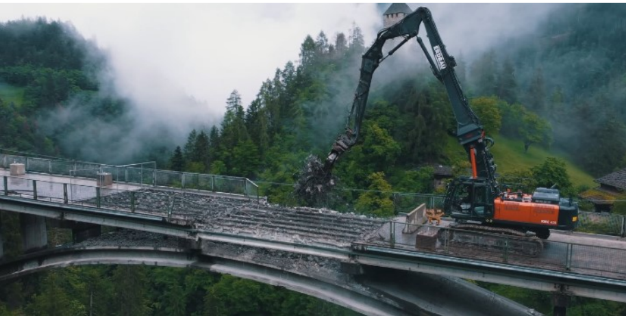
Details 1a – Abbruch Fahrbahnplatte
