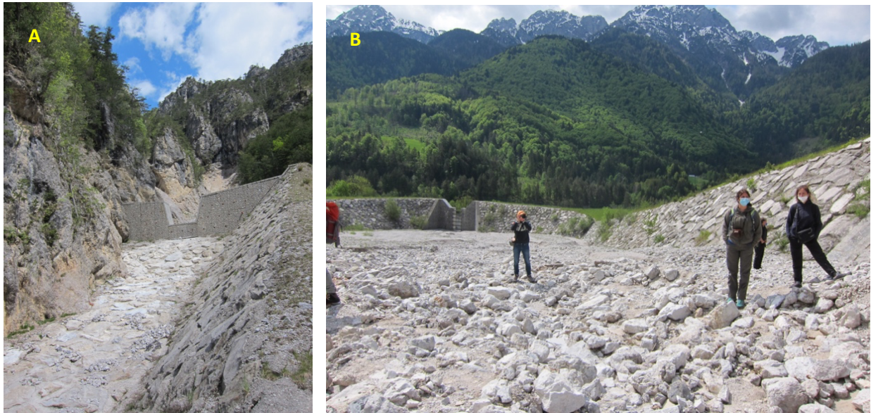
Figura 5. Ispezione delle strutture di protezione idraulica nel bacino idrografico del Rio Cucco. a) Barriera nel tratto più a monte del canale. b) Zona di deposizione nel tratto più a valle del canale.
