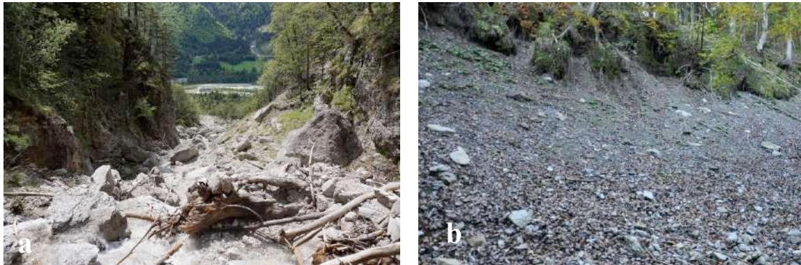
Figura 13. Esempi di sponde descritte durante l'indagine: a) sponda sinistra in roccia, sponda destra in deposito di versante (Rio Cucco); b) sponda in erosione (Rio Drigniza).
