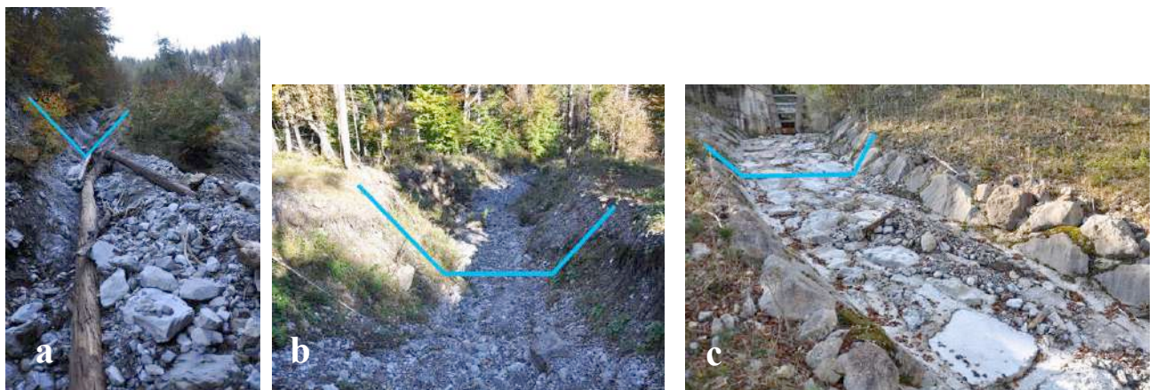
Figura 11. Esempio di alvei rilevati nei bacini di prova: a) a V con detriti; b) a forma trapezoidale con detriti; c) a forma trapezoidale canalizzata.
