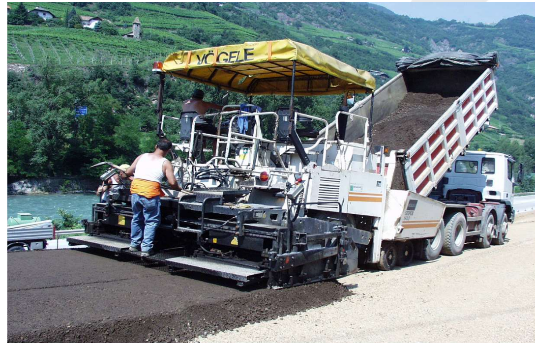
Stesa del misto cementato con fresato ed emulsione bituminosa
