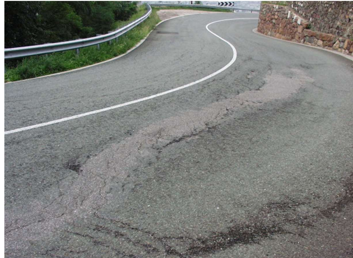
S.P.73 Renon – Stato della pavimentazione prima dell'intervento
