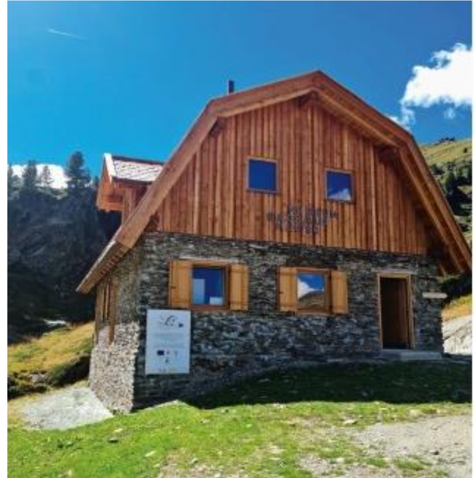
Renovierung des „Badhaus Zufall“ (Gemeinde Martell) / Restauro del “Badhaus Zufall” (Comune di Martello)
