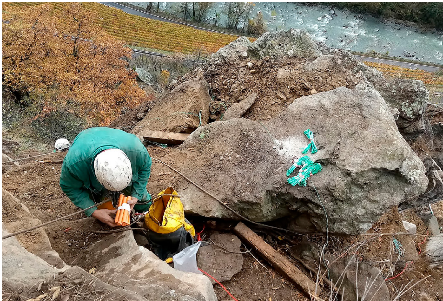
Le operazioni propedeutiche al brillamento dei massi pericolanti: un tecnico sistema l'esplosivo
