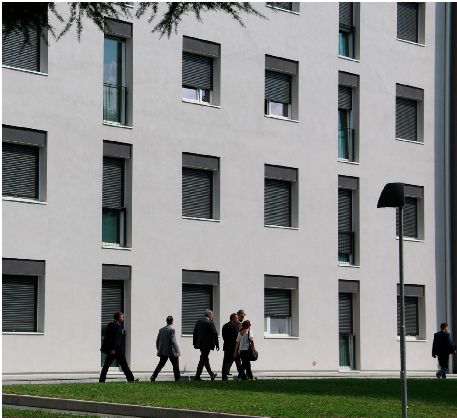
In Bozen, Meran, Brixen, Bruneck und Sterzing wurden Wohnungen für Berufssoldaten errichtet, im Bild ein Wohngebäude in Meran.
