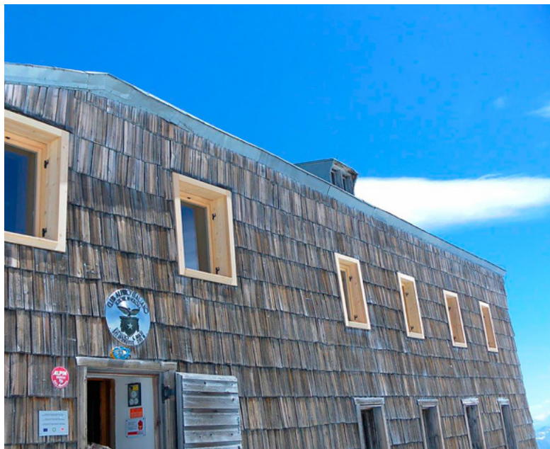
Eine Reihe von Schutzhütten ist 1999 vom Staat ans Land übergegangen.
