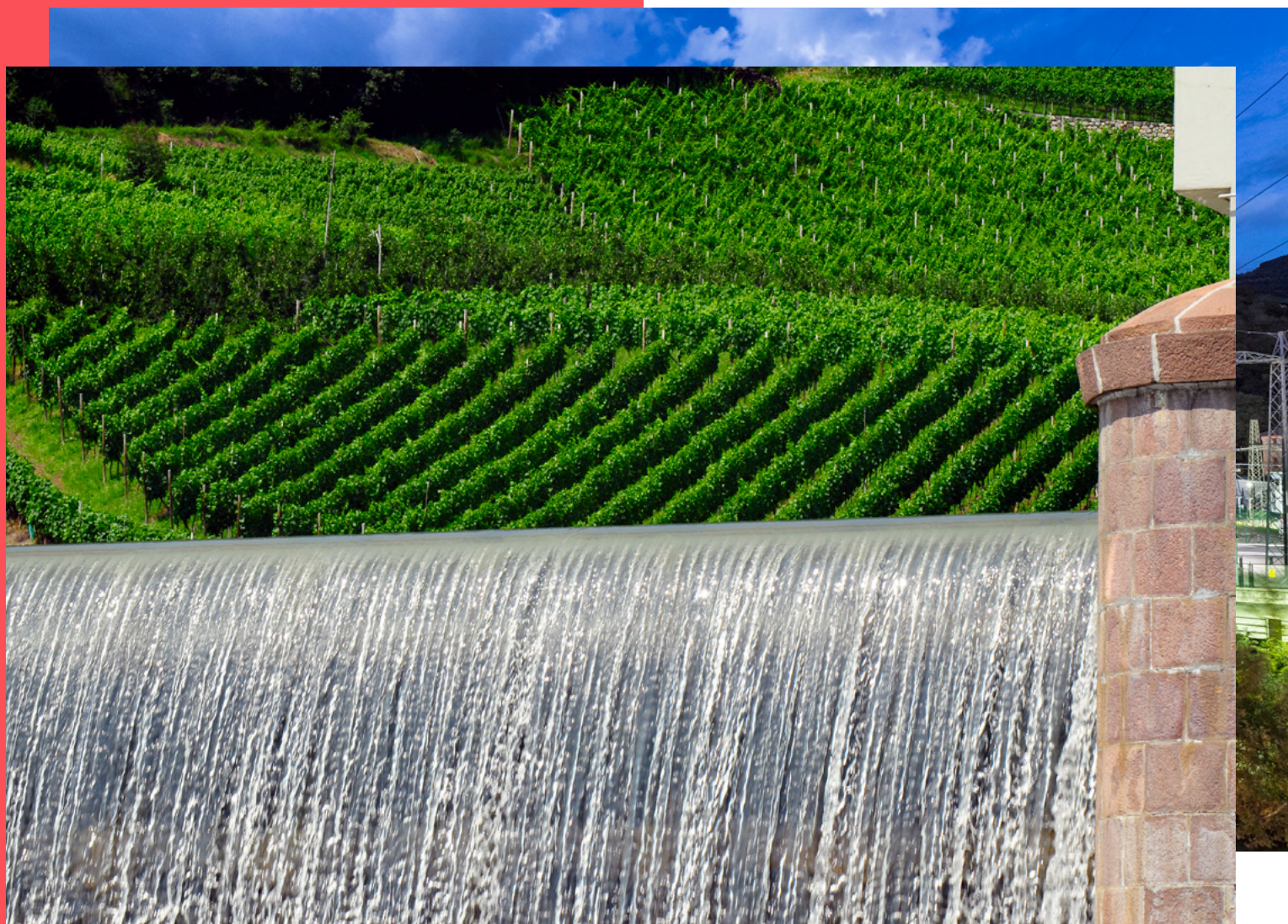
Opera di presa sull'Isarco della centrale Alperia di Barbiano all'altezza dell'imbocco della Val di Funes
