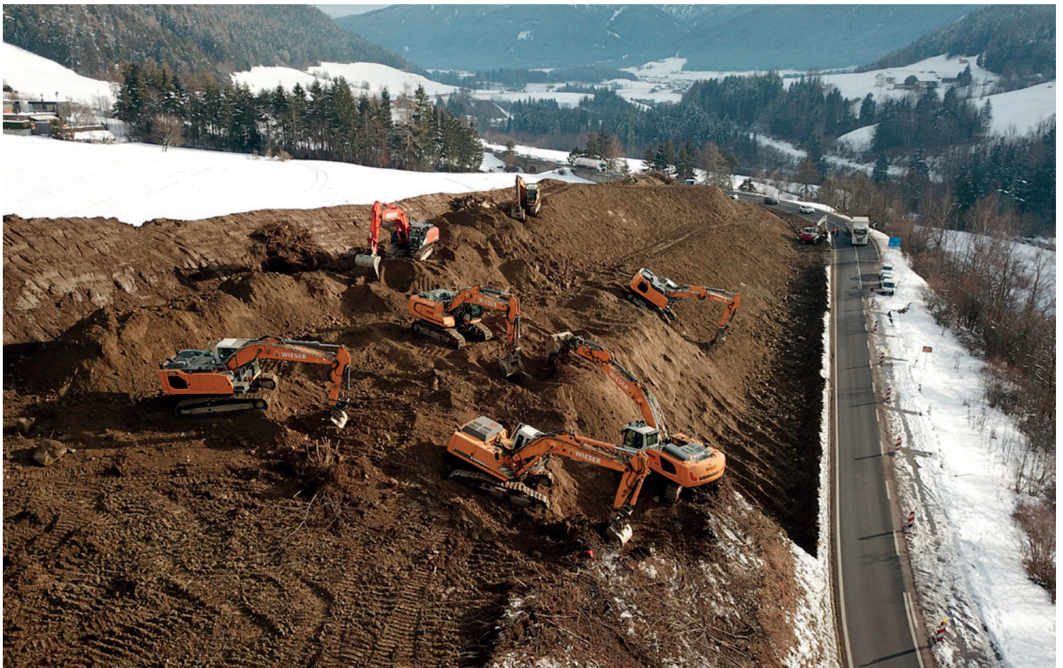
Der Dringlichkeitseingriff in Percha zu Weihnachten 2020 war beispielhaft für die Zusammenarbeit von Land, Gemeinden, Grundbesitzern, Planern, Firmen und Mitarbeiter.
