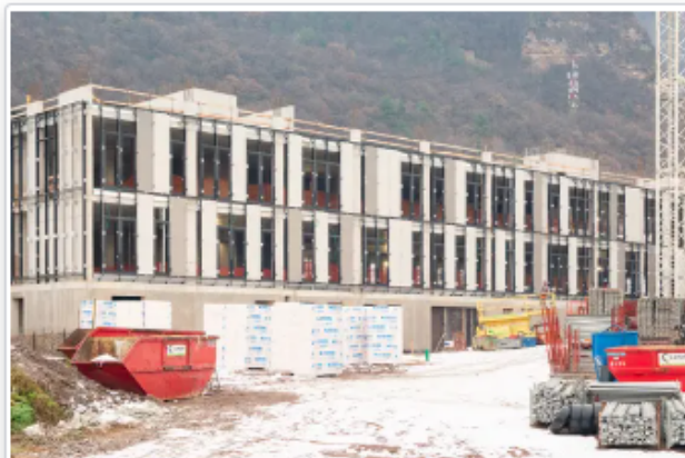
Foto: cantiere della Casa delle comunità Laives, Ripartizione edilizia e servizi tecnici della Provincia Autonoma di Bolzano
