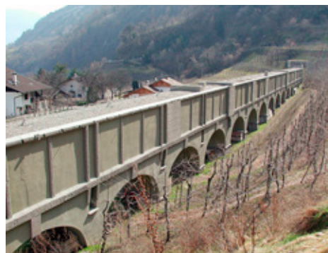
La centrale di Marlengo
