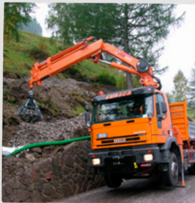
Sichere Straßen bis in die Foto: Landesabteilung Straßendienst
