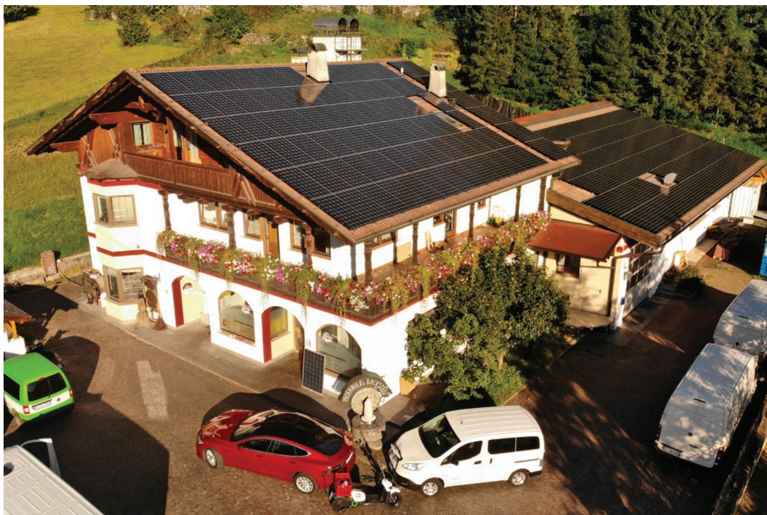
Blick auf die Dächer des Betriebes: Photovoltaik statt Ziegel.
