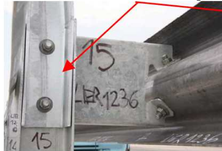
Corrimano BPC imbullonato sul paletto PAB H2 CE = PAB H2 BPC
