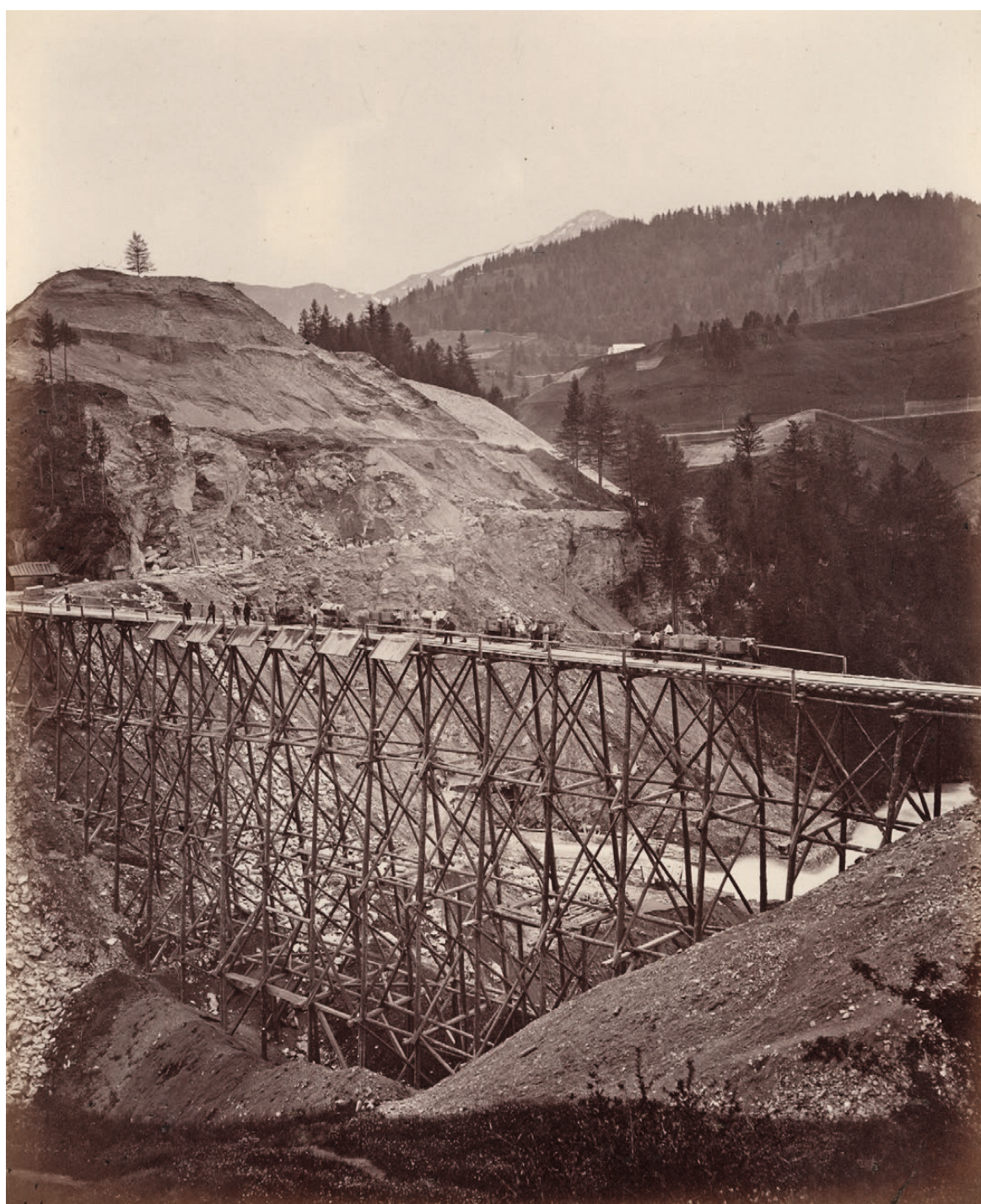
Impalcatura per la costruzione della ferrovia presso il Schlossberg di Mauterbach al Brennero, giugno 1866
