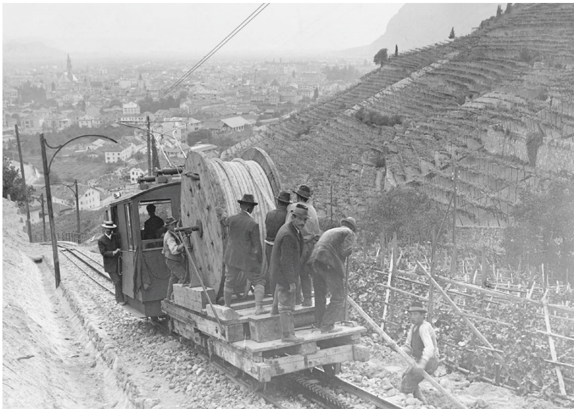
Stromkabelverlegung entlang der Strecke der Rittnerbahn; Signat, 1907
