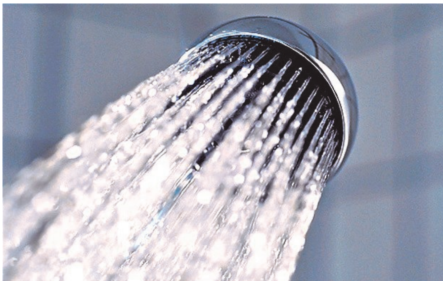
Doccette sporche ed incrostate aiutano la formazione di gocce d'acqua contenenti il batterio della legionella.
