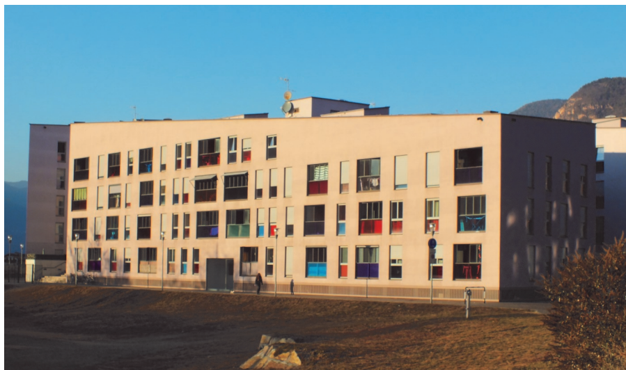
Ein modernes Gebäude des Institutes im Stadtviertel „Kaiserau“ in Bozen.
