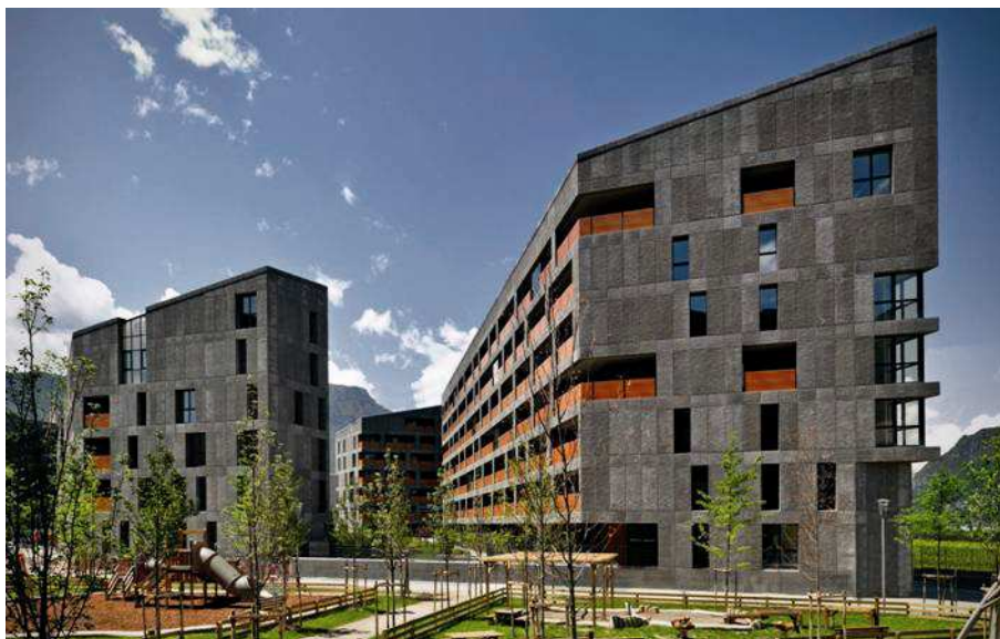
Das Baulos EA2 mit 136 Wohnungen in der Kaiserau in Bozen, in welchem auch die ersten Mittelstandswohnungen den Mietern übergeben wurden.
