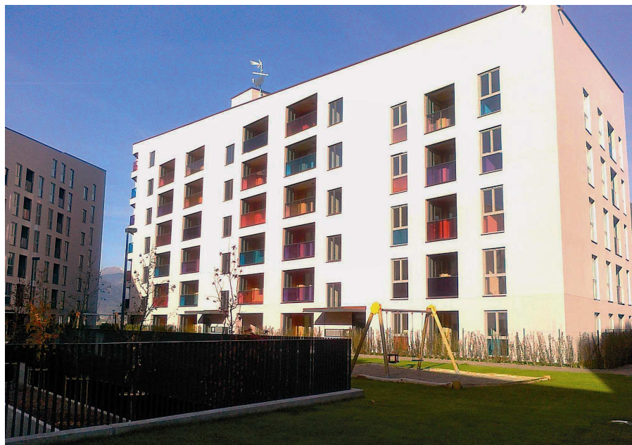
Ansicht der Gebäude des Bauloses EA1 in der Kaiserau vom Innenhof aus gesehen.
