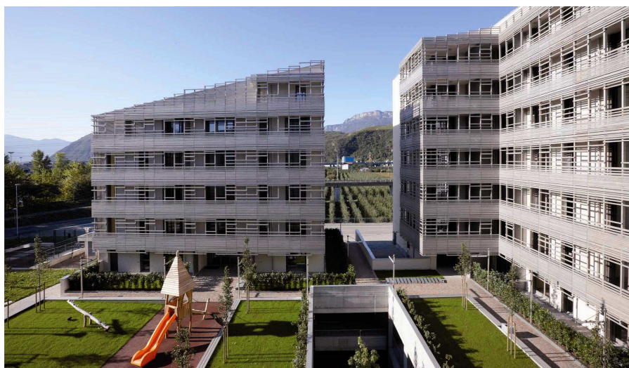
Das Baulos EA8 mit 85 Wohnungen in der Kaiserau in Bozen.
