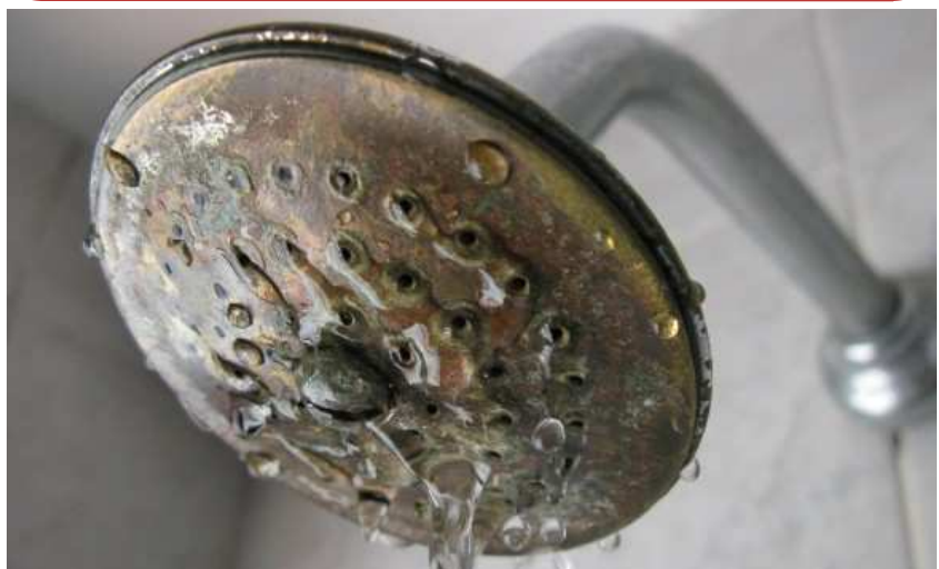
Schmutzige und verkrustete Duschköpfe unterstützen die Bildung von legionellenhaltigen Wassertropfchen.
