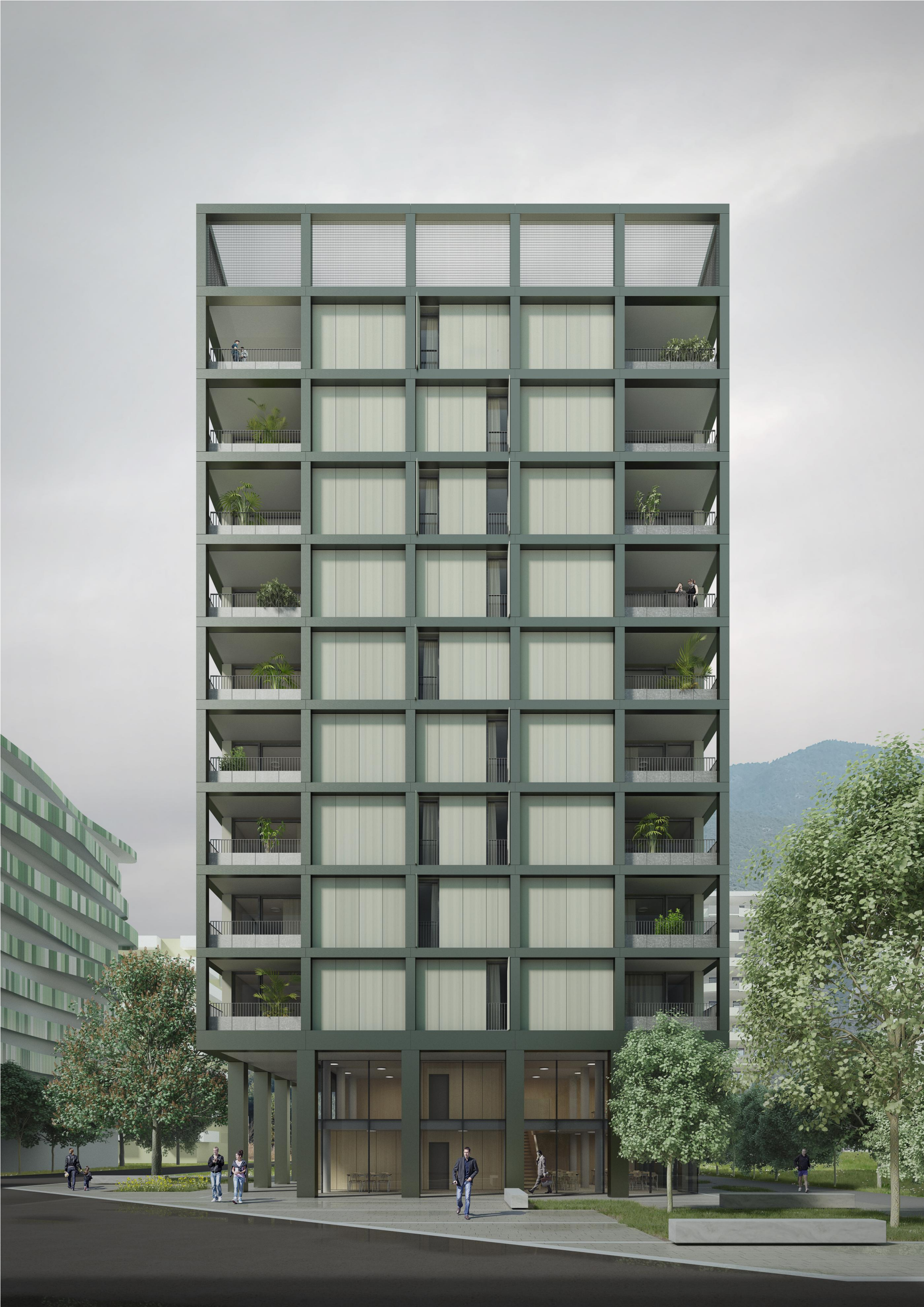
■ Vista fronte Sud
