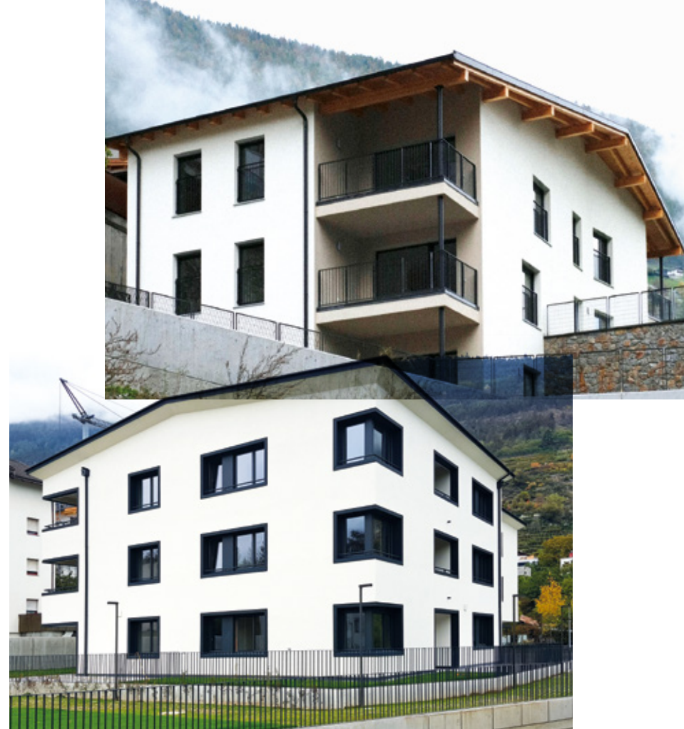
Oben: Neubau in Martell Sotto: nuova costruzione a Silandro
