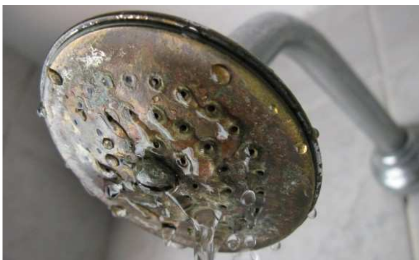
Doccette sporche ed incrostate aiutano la formazione di gocce d'acqua contenenti il batterio della legionella.
