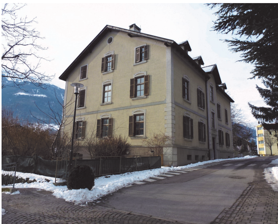
L'edificio dell'ex casa di riposo prima del risanamento.
