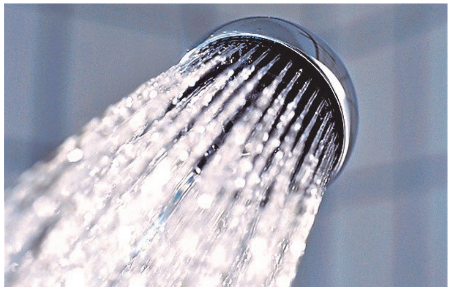
Schmutzige und verkrustete Duschköpfen unterstützen die Bildung von legionellenhaltigen Wassertropfchen.
