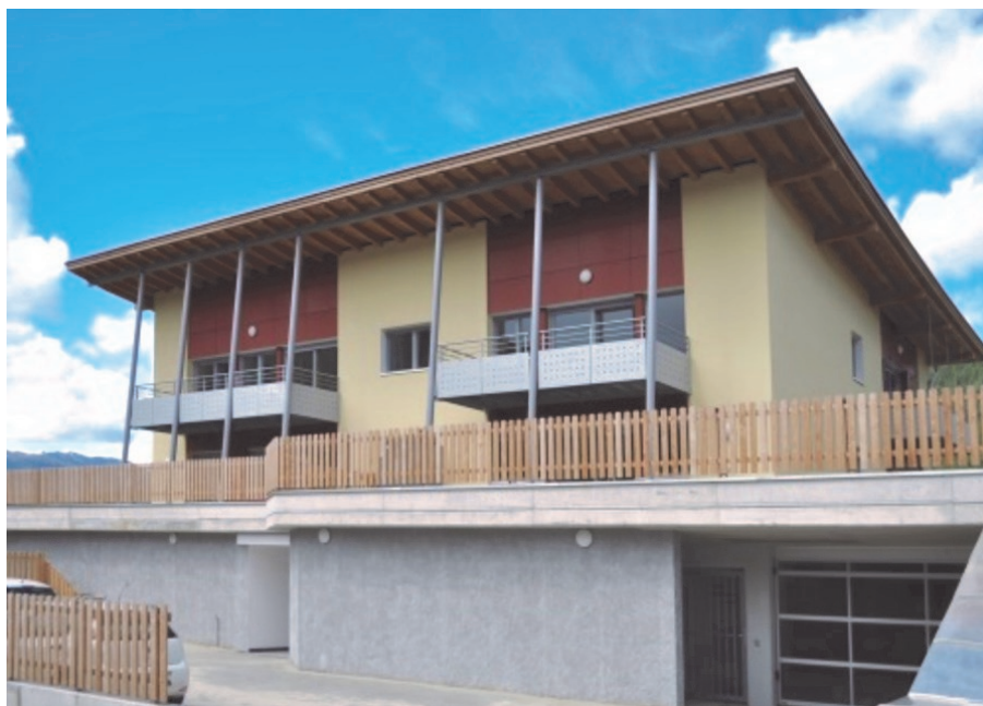
Nuovo edificio Ipes di 7 alloggi a Valdaora
