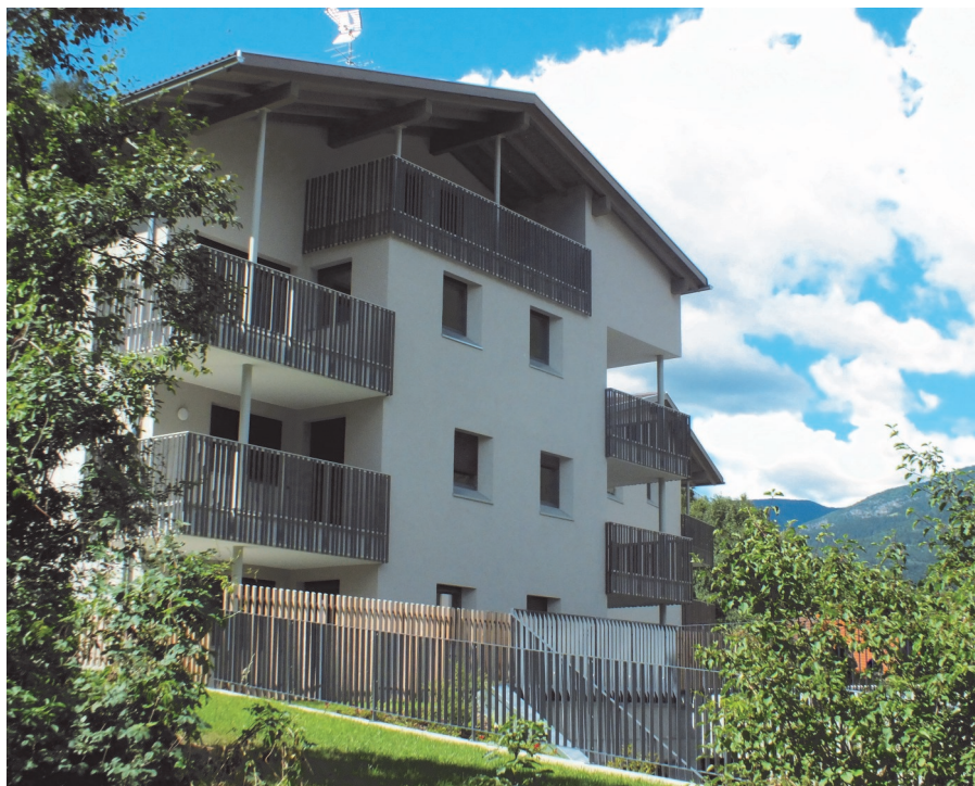
L'edificio nuovo con 15 alloggi a Chiusa - Seebegg 42 - 44.
