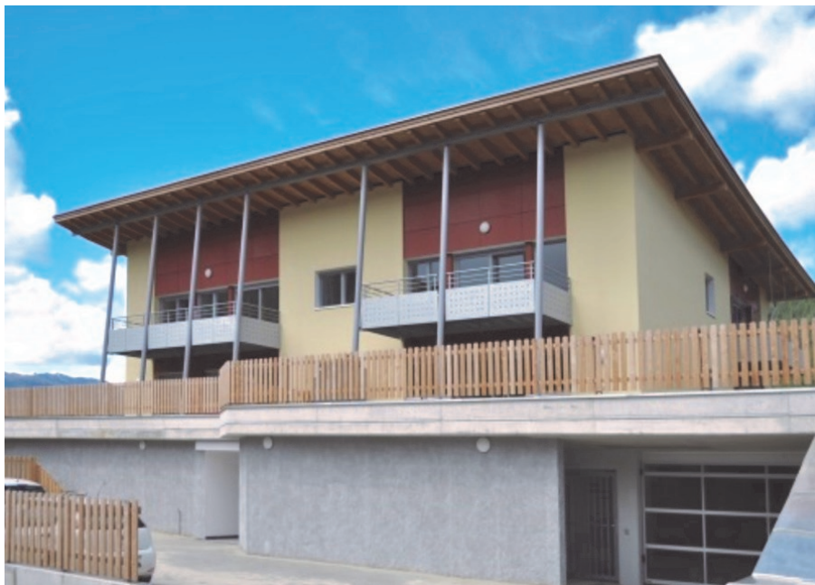
Neubau des Wohnbauinstitutes in Olang mit 7 Sozialwohnungen.
