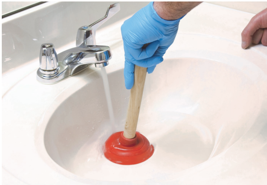
Verstopfungen durch Abfälle sollten vermieden werden.
