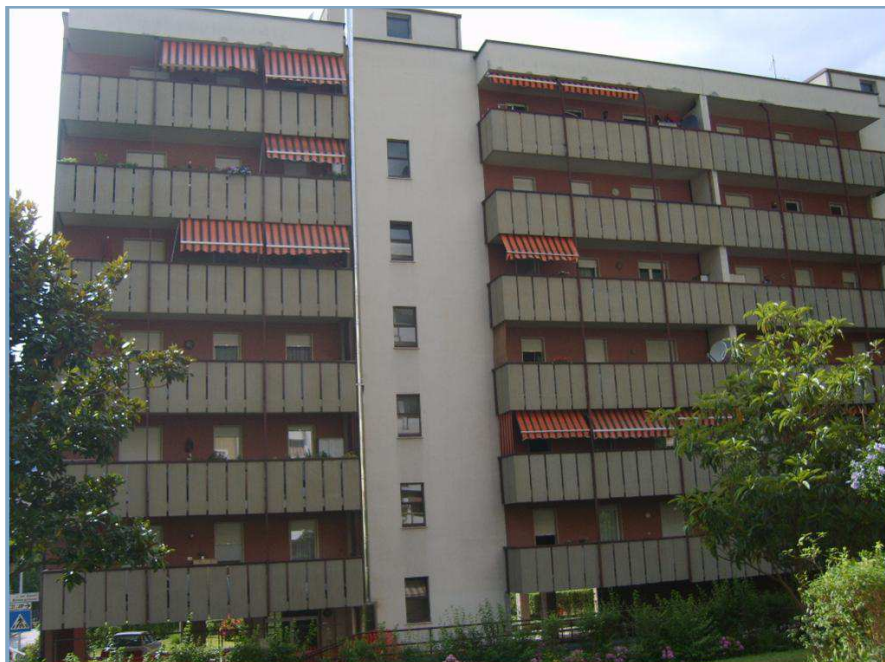
L'edificio a Laives, via Vigneti 21-23 prima del risanamento ...
