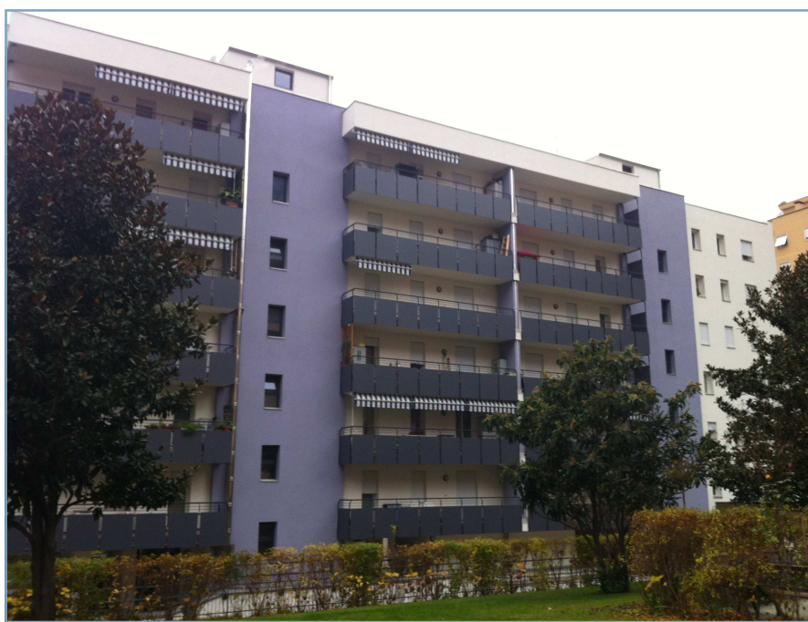
... e dopo l'intervento di risanamento.
