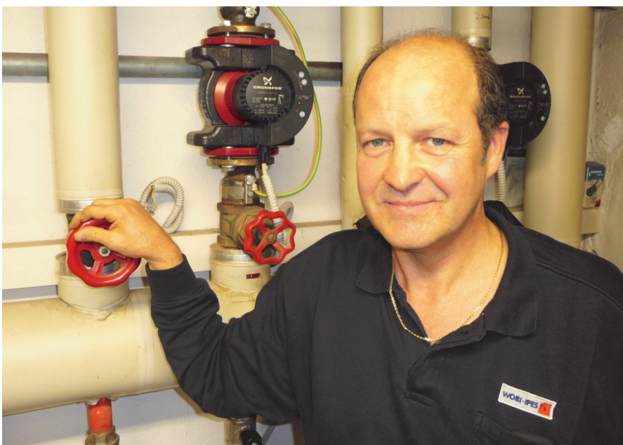
Erich Gruber ist mit Leib und Seele Heizwart beim Wohnbauinstitut.
